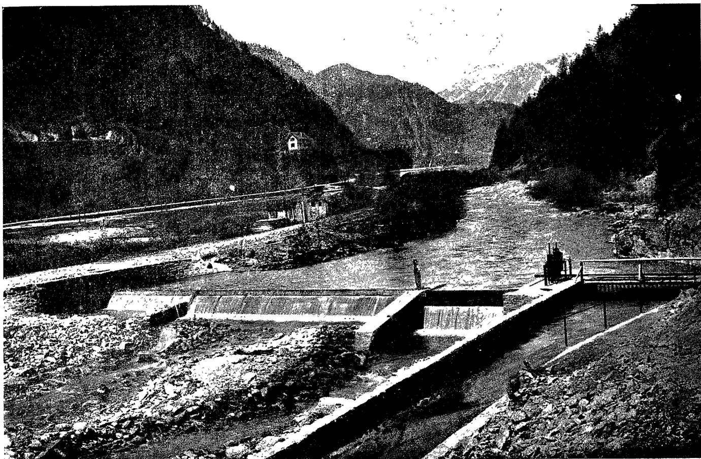
Fig. 19. — Vue d'aval du barrage dans le Tessin, à Piotta
