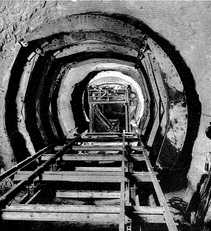
Le bassin d'expansion à l'extrémité supérieure de la cheminée d'équilibre.
