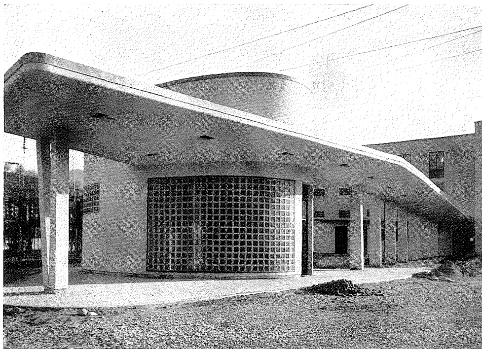
Bâtiments situés au sommet du puits des barres. A droite la salle des appareillages et tableaux.
