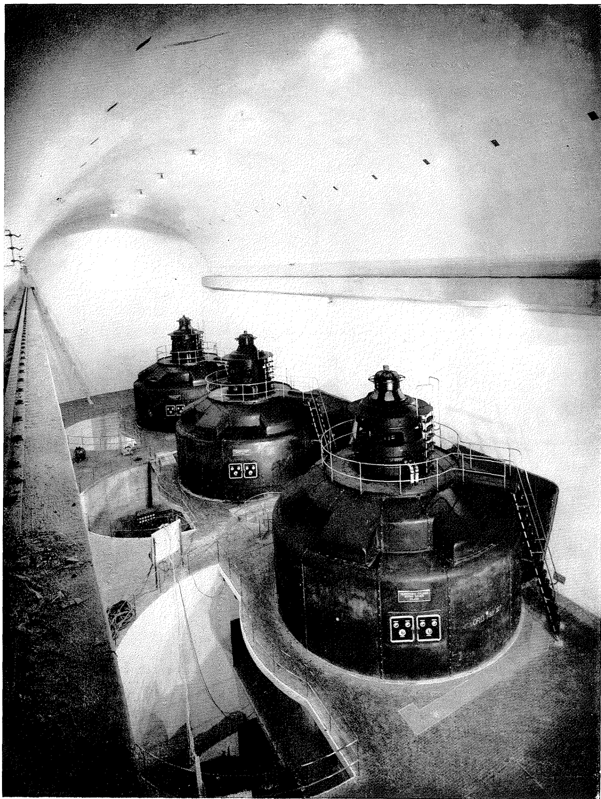
La salle des machines à la fin du montage.
