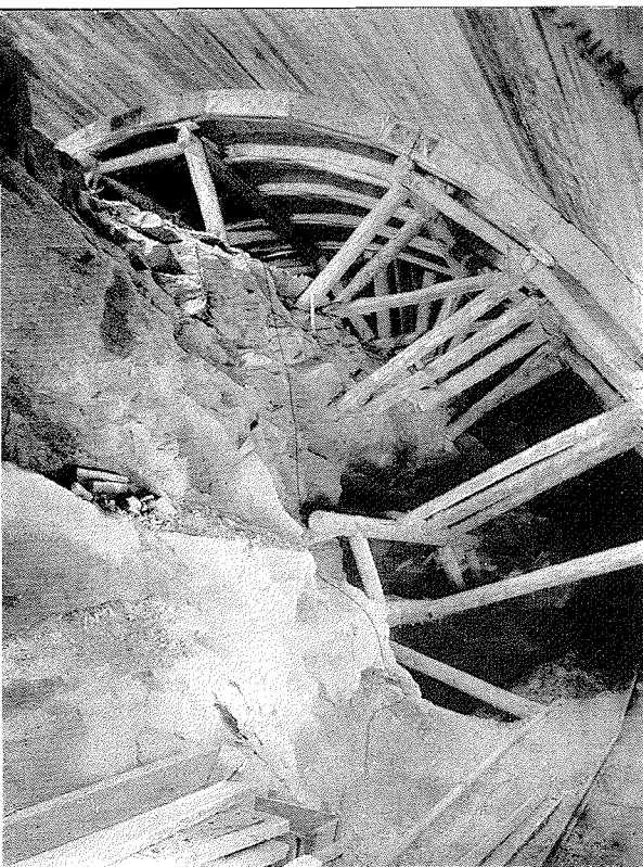
Travaux de perforation et de revêtement au niveau de la voûte de la centrale.
