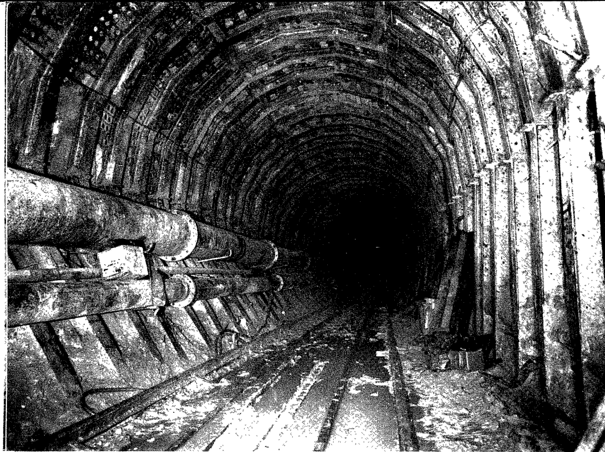
GALERIE D'AMENÉE. Cintres de soutènement au PM 3 700. Zone des cargneules.
