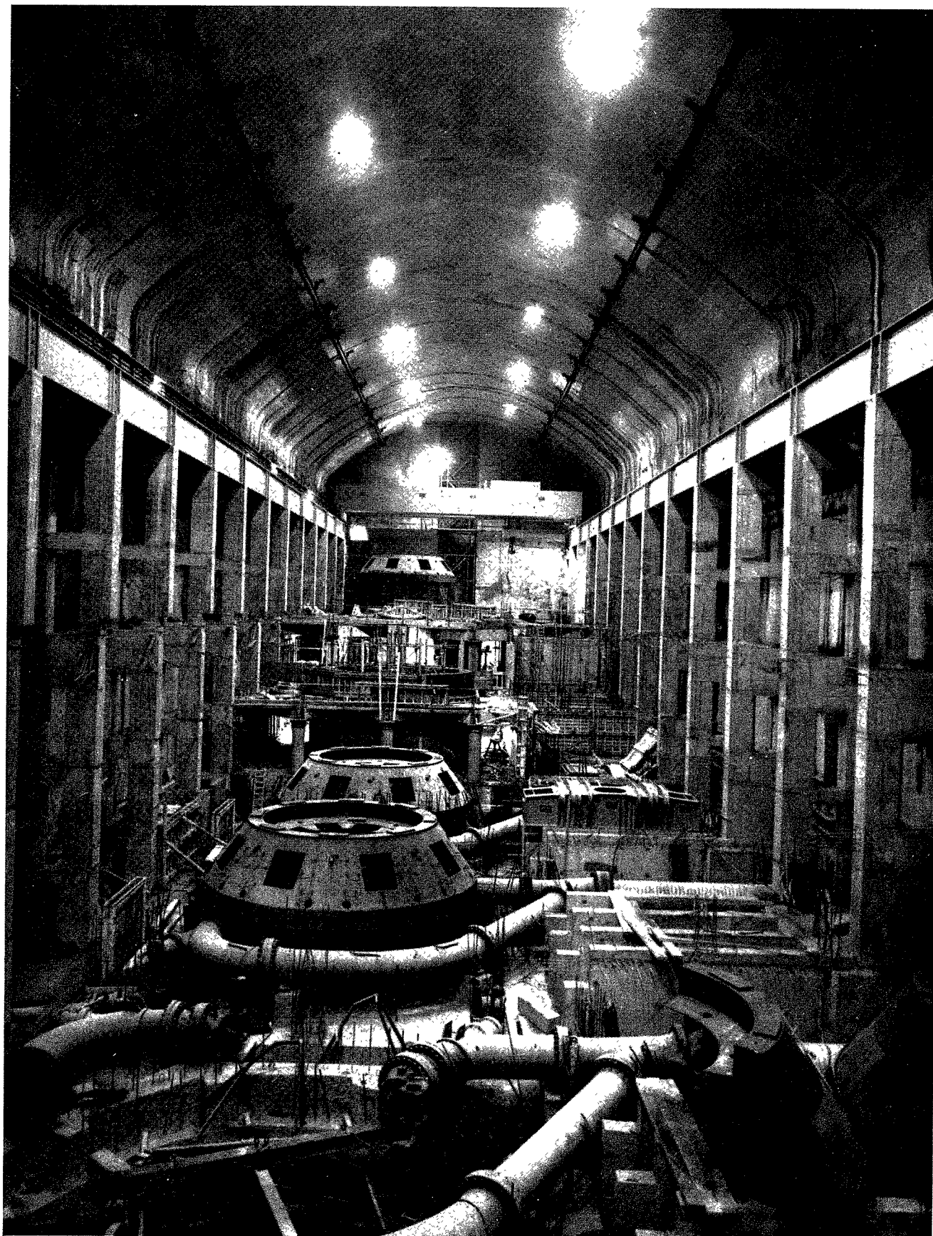
MONTAGE DES GROUPES DE L'USINE DE LA BATHIE
