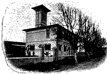
FIG. 2. — Sous station d'Antibes.
