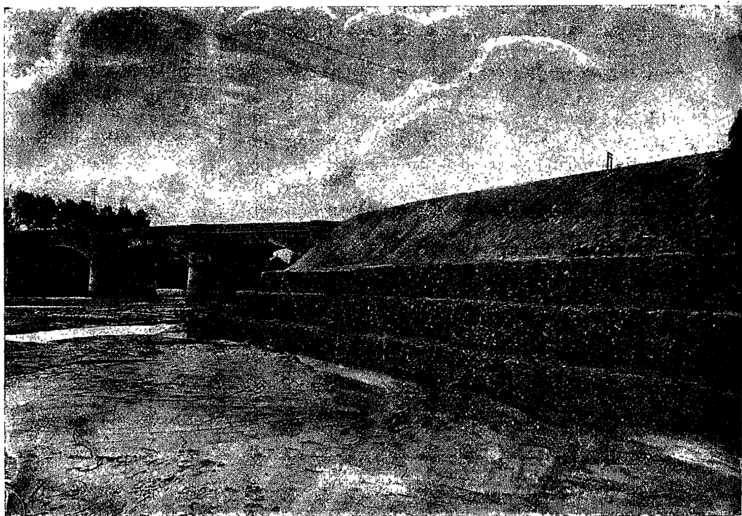
TRAVAUX EXÉCUTÉS EN 1906 PAR LA COMPAGNIE DES CHEMINS DE FER DU MIDI SUR LA LIGNE BOLOGNE-OTRANTE, PRÈS D'IMOLA SUR LA RIVE DROITE DU TORRENT SANTERNO
