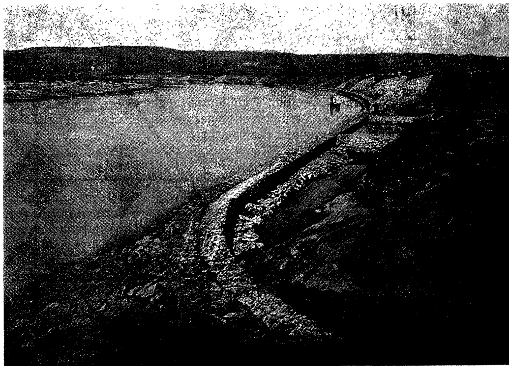
TRAVAUX DE DÉFENSE EN « GABIONS PALVIS » EXÉCUTÉS EN 1906 PAR LE GÉNIE CIVIL DE ROME SUR LES RIVES DU TIBRE
