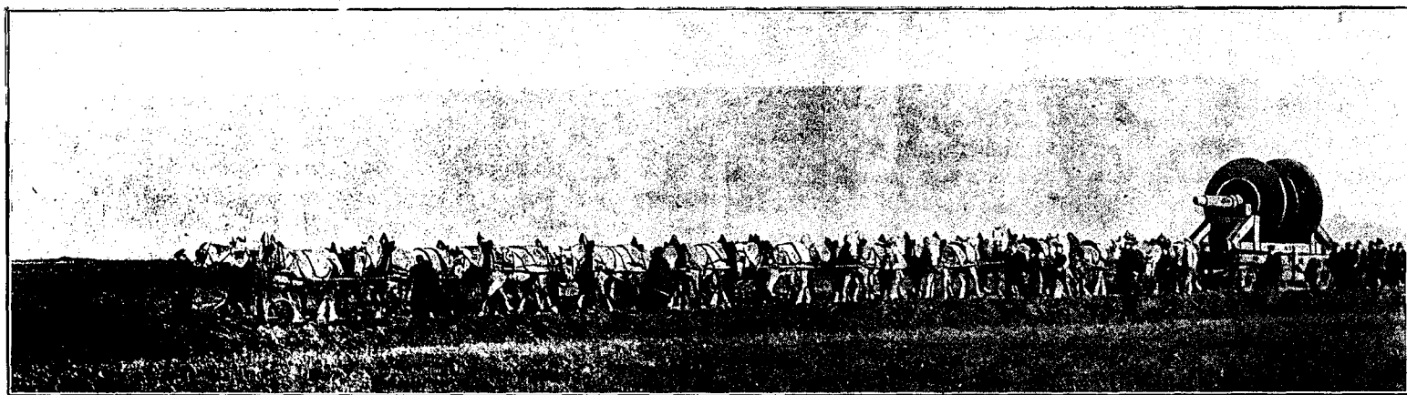
TRANSPORT DU ROTOR D'UNE TURBINE A VAPEUR DE 25 000 CHEVAUX, PIÈCE PESANT 38 TONNES
