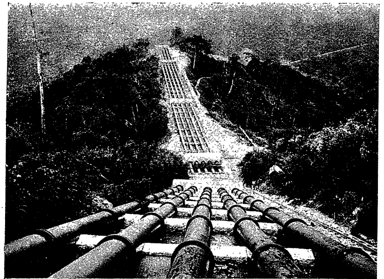
CHUTE D'ITATINGA. — CONDUITES FORCÉES
