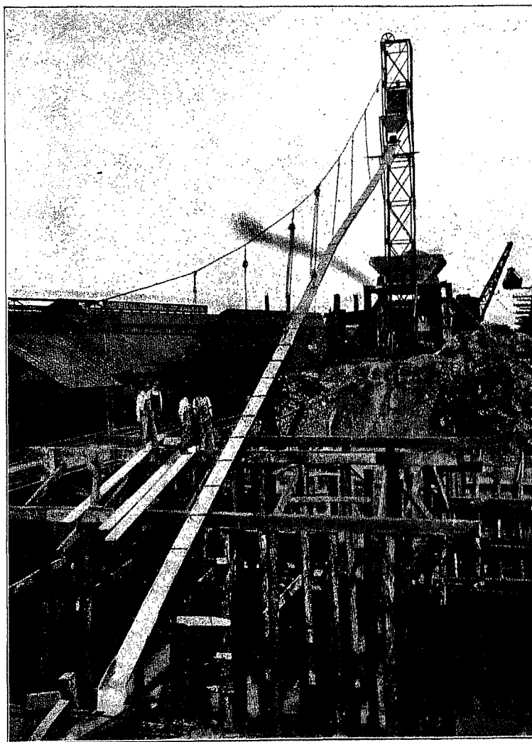
TOUR DE DISTRIBUTION DU BÉTON SUR UN GRAND CHANTIER.
