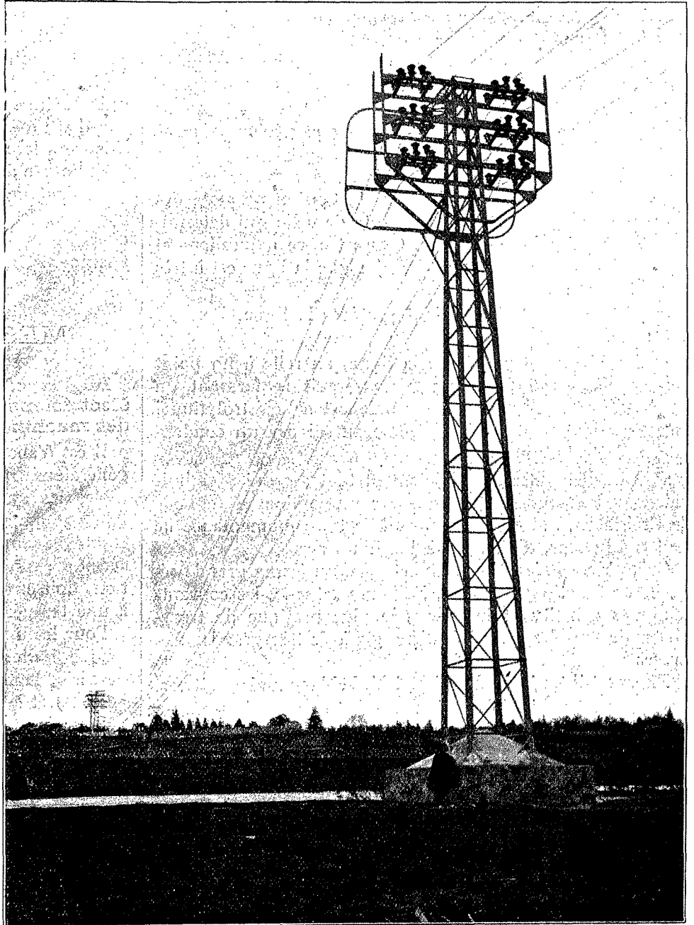
PYLONE POUR LA TRAVERSÉE DU RHONE (350 MÈTRES DE PORTÉE) (Ligne « Dauphiné-Centre » de 150 kilomètres de longueur)
