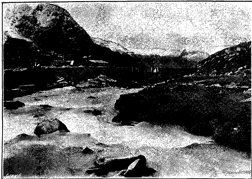
BASSIN DE MISE EN CHARGE SUR L'ADAMÈ, VIDE.
