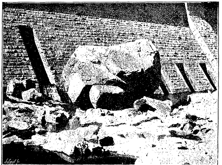
FIG. 3. — VUE AVANT DU GRAND BARRAGE D'ASSOUAN Blocs déplacés par la violence des affouillements.
