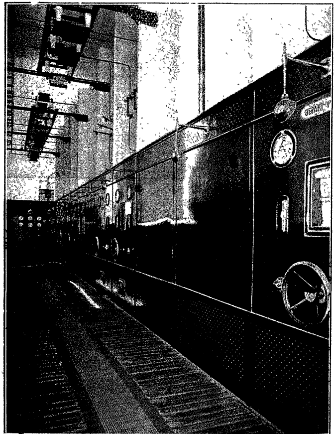
Poste de Moirans.
