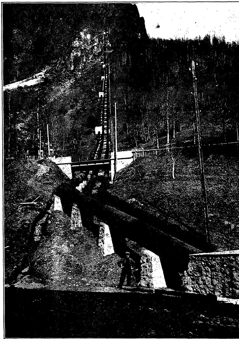
Société Hydro-Electrique de l'Eau-d'Olle. Conduites forcées du Vernay
