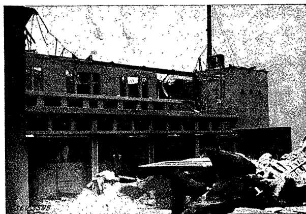
Fig. 2. — Vue d'amont de l'usine. Au premier plan l'emplacement de la rupture.
