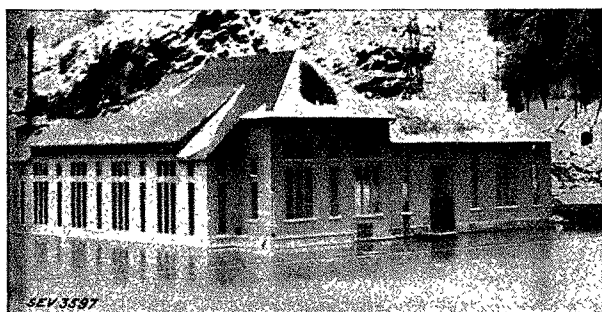
Fig. 1. — Vue d'aval de l'usine après la catastrophe. La partie gauche du toit est complètement enfoncée.
