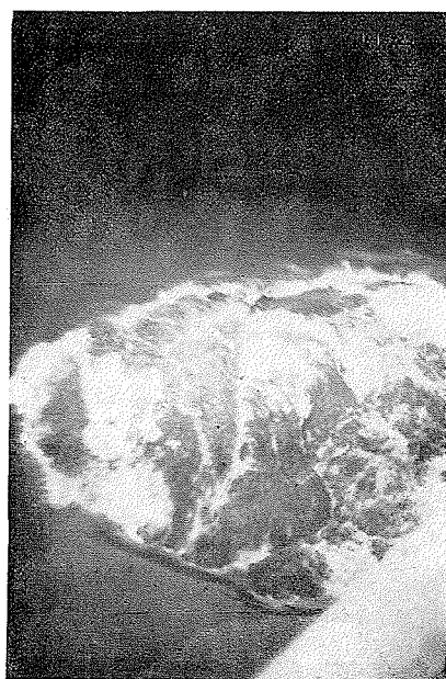
CHEMINÉE D'ÉQUILIBRE — APRÈS LE DÉCLANCHEMENT, DÉBUT DE LA FORMATION DU « CHAMPIGNON » D'EAU.
