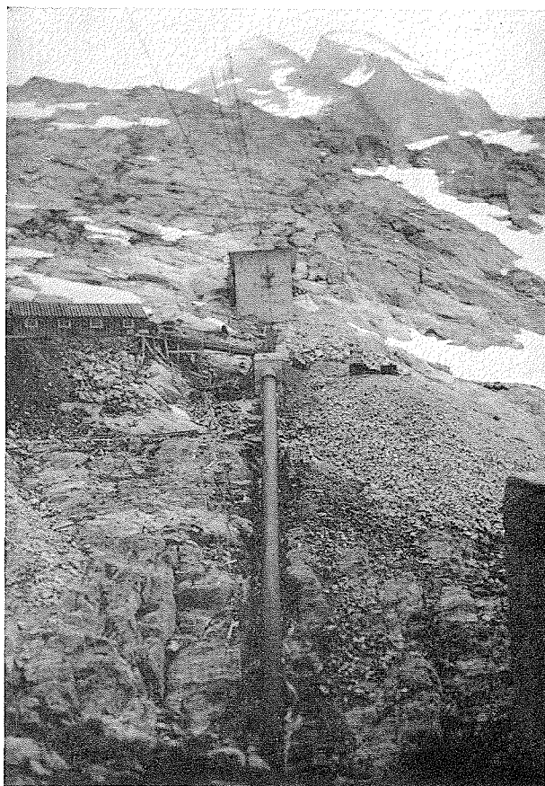
Départ amont de la conduite du Portillon. Période de montage.
