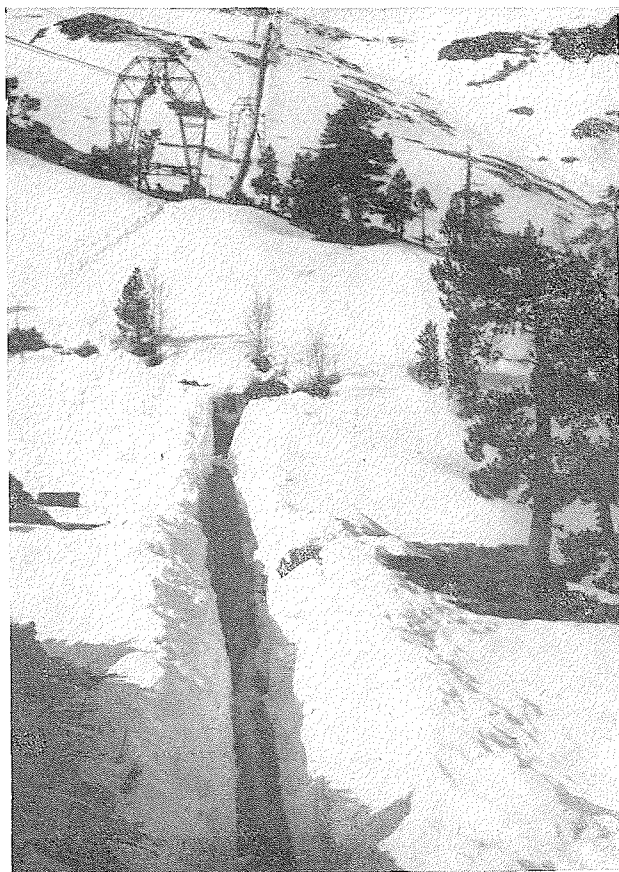
Partie haute de la conduite du Portillon au montage.
