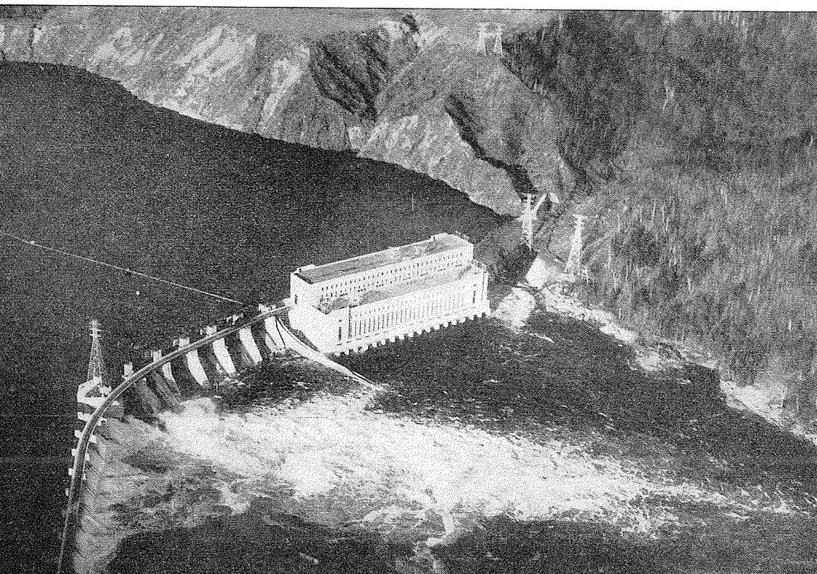
Photo n° 4. — Vue aérienne du barrage de la Gabelle, près de l'embouchure du Saint-Maurice.
