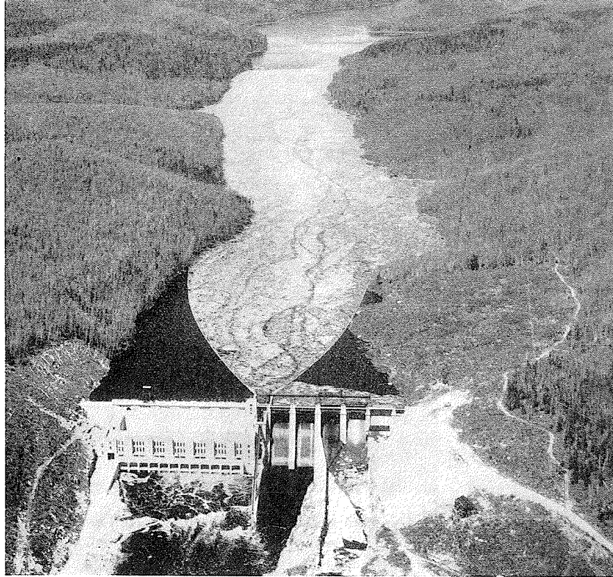
Photo n° 5. — Vue aérienne, vers l'amont, de la chute de Rapide Blanc : cette photographie illustre le problème posé par la nécessité d'assurer le flottage des bois destinés à la fabrication de la pâte à papier.
