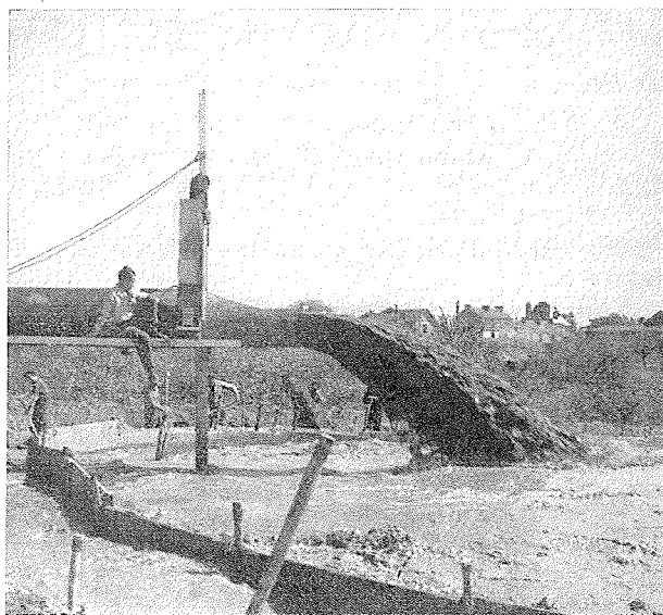
Fig. 8. — Mesures à l'installation de dragage de Nantes. Measurements being carried out on Nantes dredging site.
