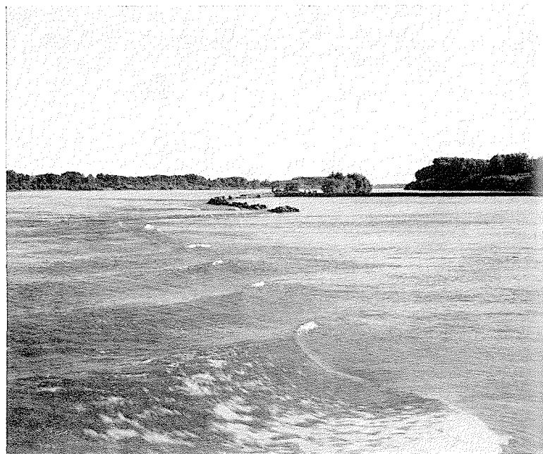
6/ Vue du secteur sinueux à lit mobile du Danube à l'aval de Paks. Au premier plan, ouvrage parallèle avec digue de jonction transversale en usage autrefois (partie marquée 2 sur la fig. 1).
