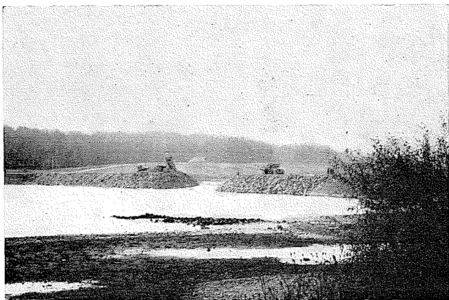
8/ Vue de la digue de coupure en cours d'exécution. Cutoff dyke construction in progress.
