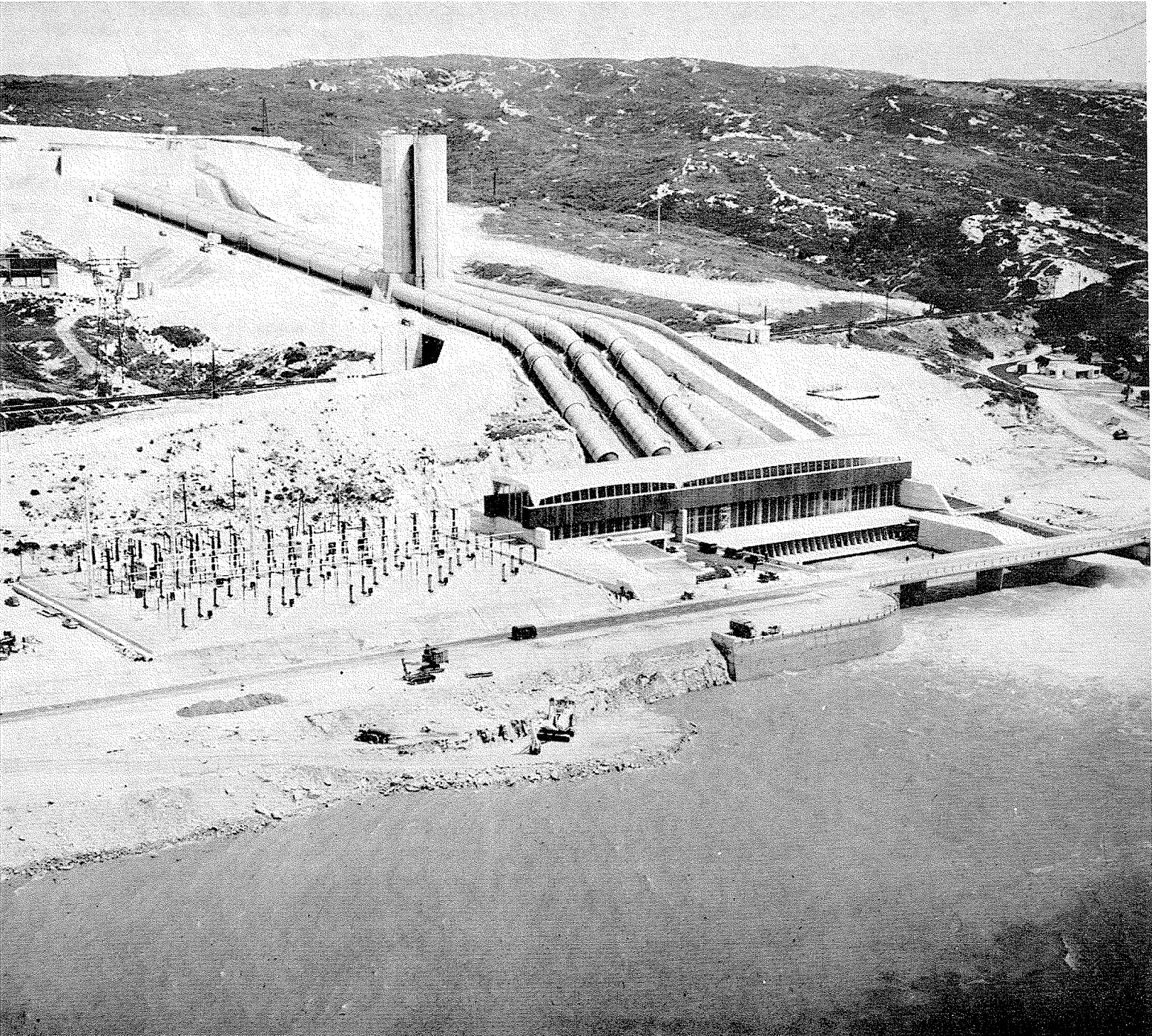
Usine de Saint-Chamas / St.-Chamas plant.
