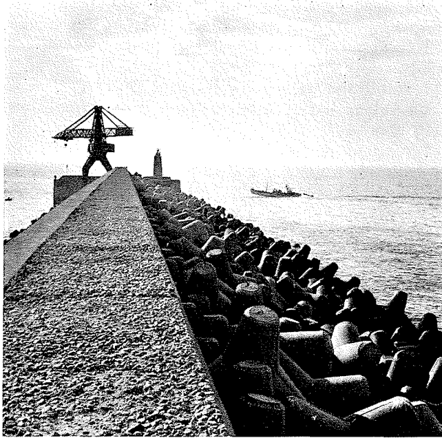
5/ Leixoes (près de Porto), Portugal. — Surélévation du brise-lames principal. Les travaux exécutés en 1967 et 1968 ont comporté l'emploi de 2 600 tétrapodes de 16 m 3 (40 t). Les études expérimentales furent effectuées en 1966 à Lisbonne par le L.N.E.C. (Laboratorio Nacional de Engenharia Civil).
