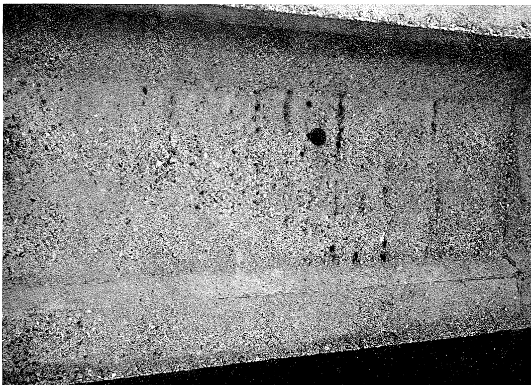
6/ Pont-route sur pertuis : poutre préfabriquée.
