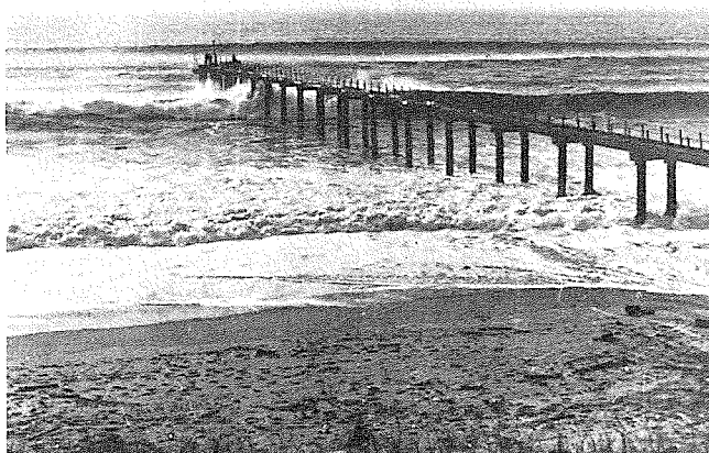
4 / Prise d'eau de Seignosse (Cliché SOGREAH)
