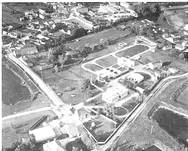
Figure 4 Vue générale des installations (Phot'r - cliché aéroport Lille Lesquin)
