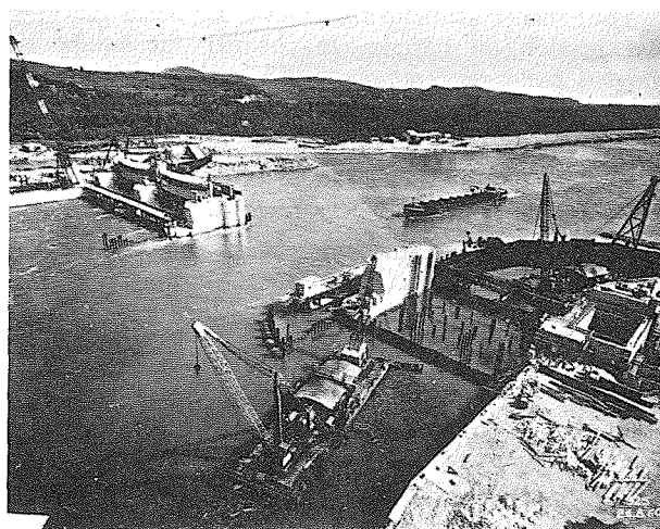
Vue générale du chantier, 3 e phase (août 1960).
