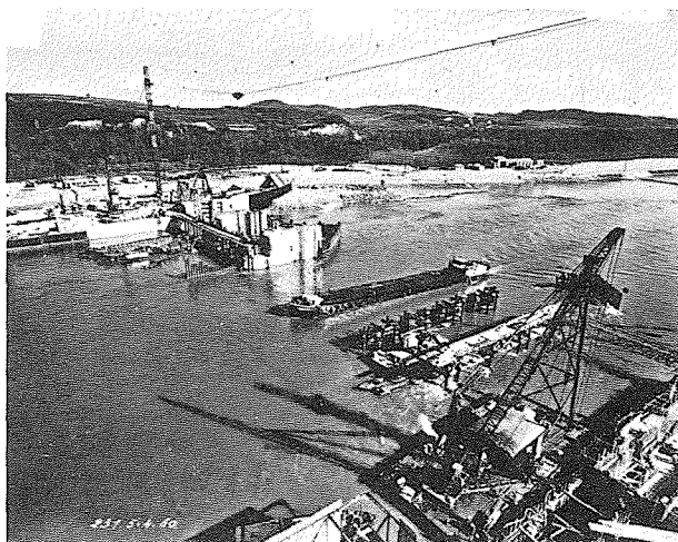
Vue générale du chantier 2 e phase (avril 1960).
