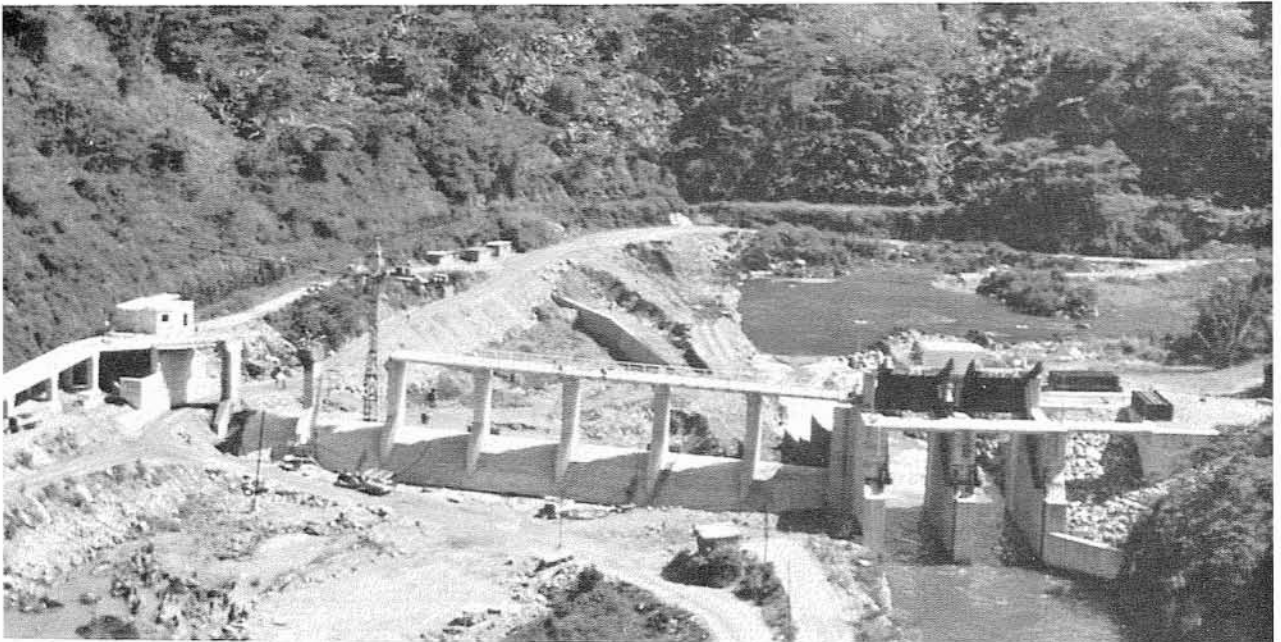
Figure 10. — Vue aval du barrage pendant la construction.
