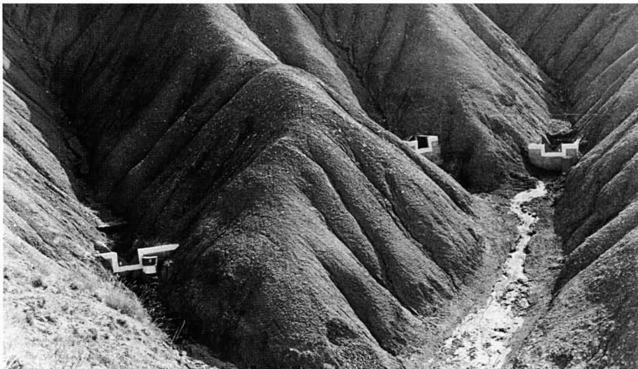
2. Vue d'ensemble des 3 ravines élémentaires équipées de fosses à sédiments.
