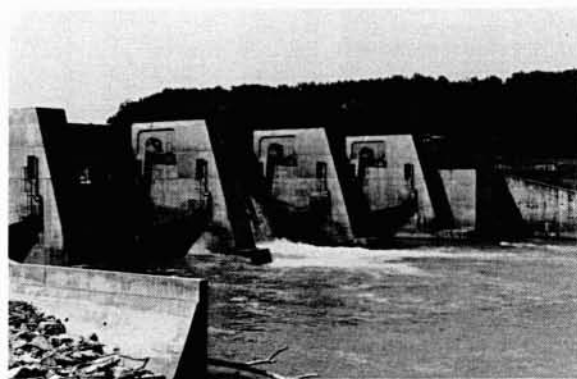
8. Barrage de Villebois — vue d'aval RD.
