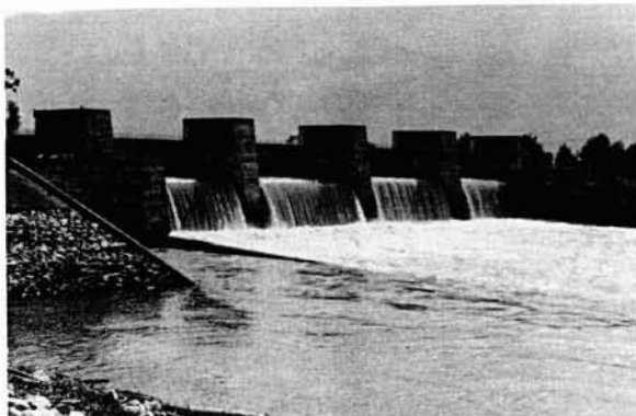
5. Barrage de Champagneux — vue d'aval RD.
