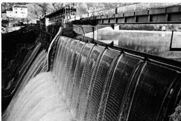
Premier essai de déversement sur le nouveau clapet (25 novembre 1988).
