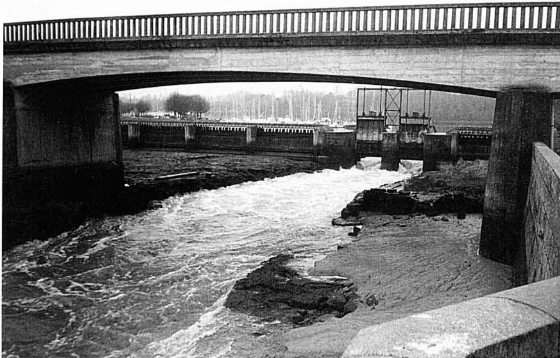
Photo n° 3 : Chasse hydraulique expérimentale par les vannes de l'écluse du Chatelier.
