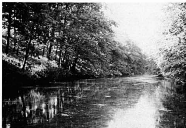
1. Vestiges de la Fosse caroline près de la localité de Graben : deux hauts remblais bordent une pièce d'eau longue de 300 m.
