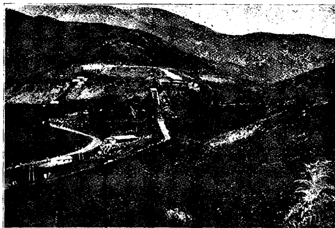
Fig. 10. — Vue du deverson, du canal de décharge. du château-d'eau et des conduites forcées de l'usine de Florida-Alta
