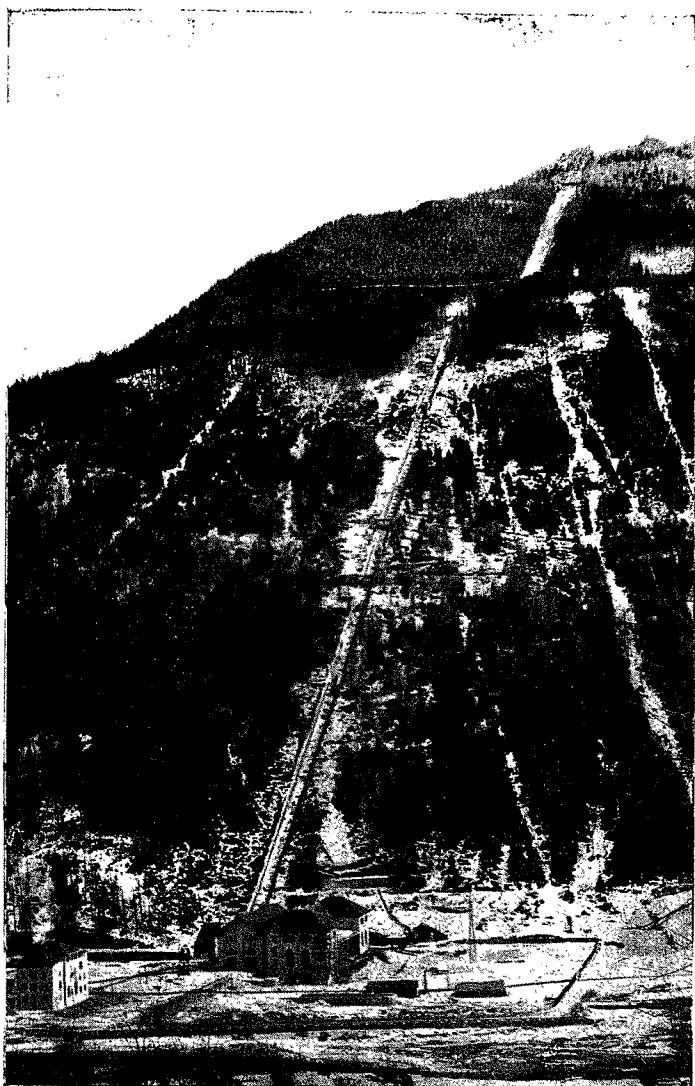
Conduite forcée et Centrale du Temu
