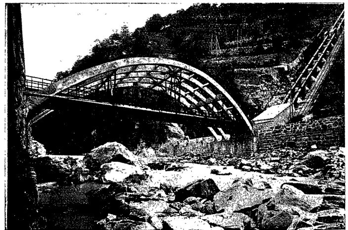
Traversée du Lys près de la centrale de Pont-Saint Martin
