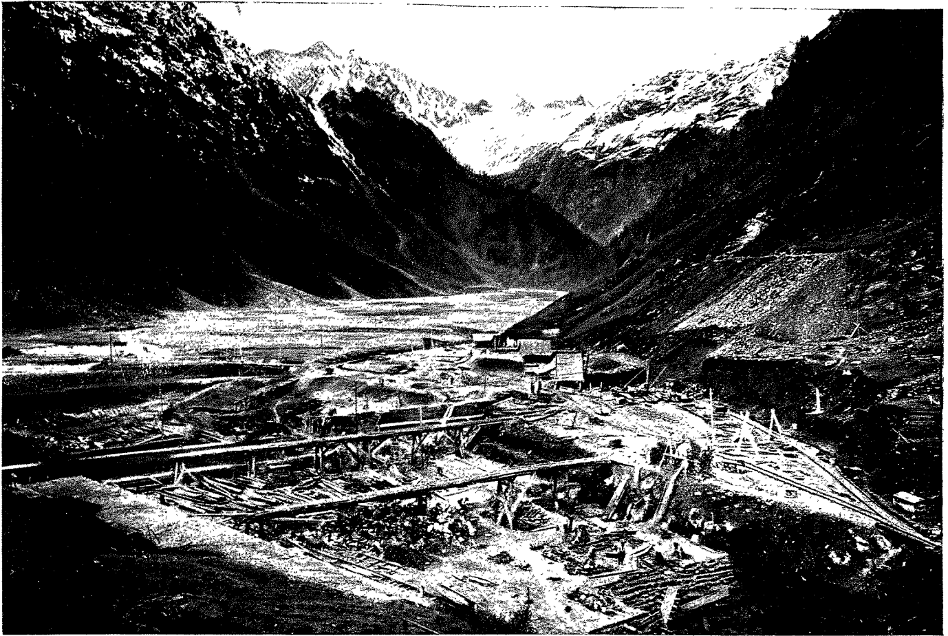
Installation de l'Ovesca — Construction de la digue de l'Alpe Cavalli
