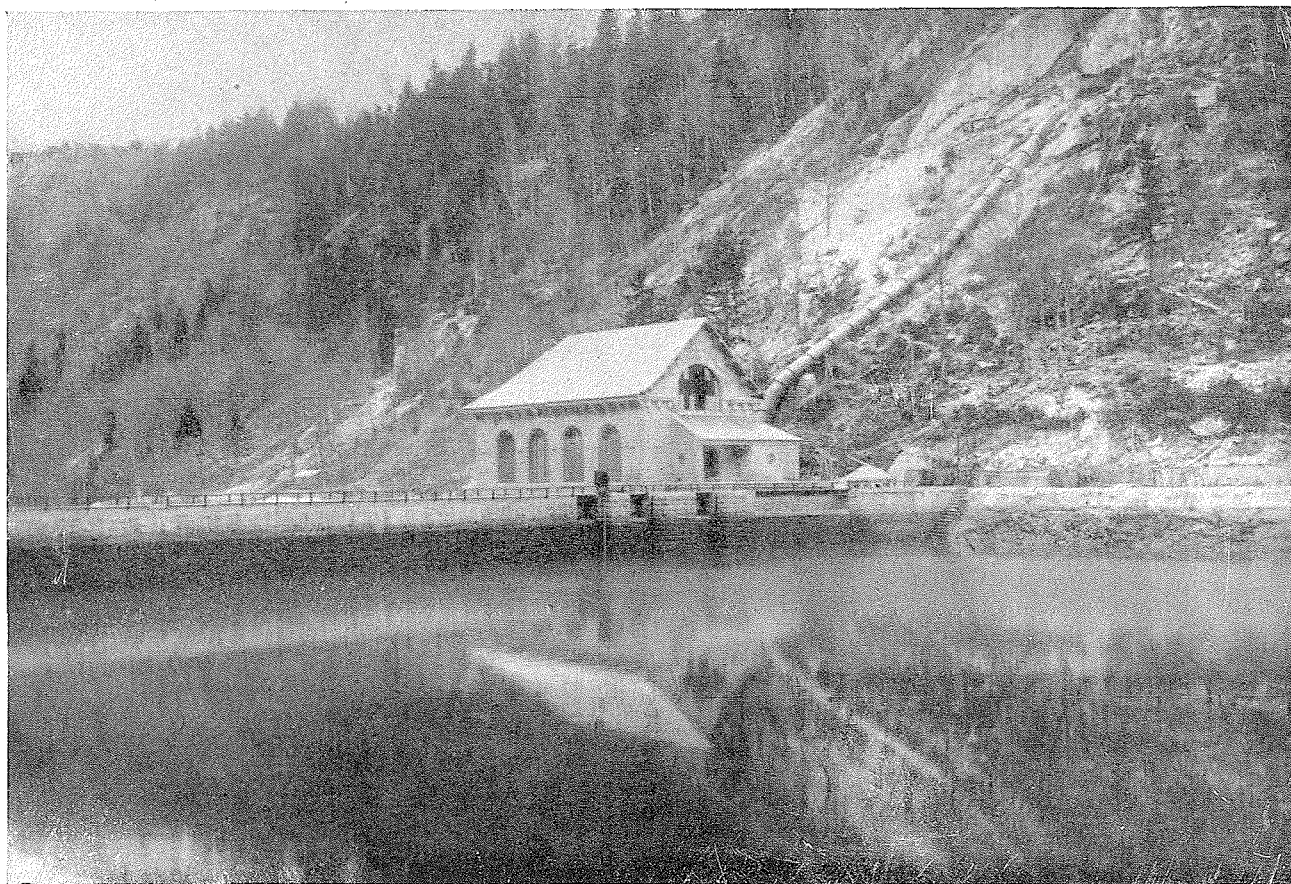
Fig. 5. — Le bâtiment d'usine de Fabrèges, vu de l'usine d'Artouste.
