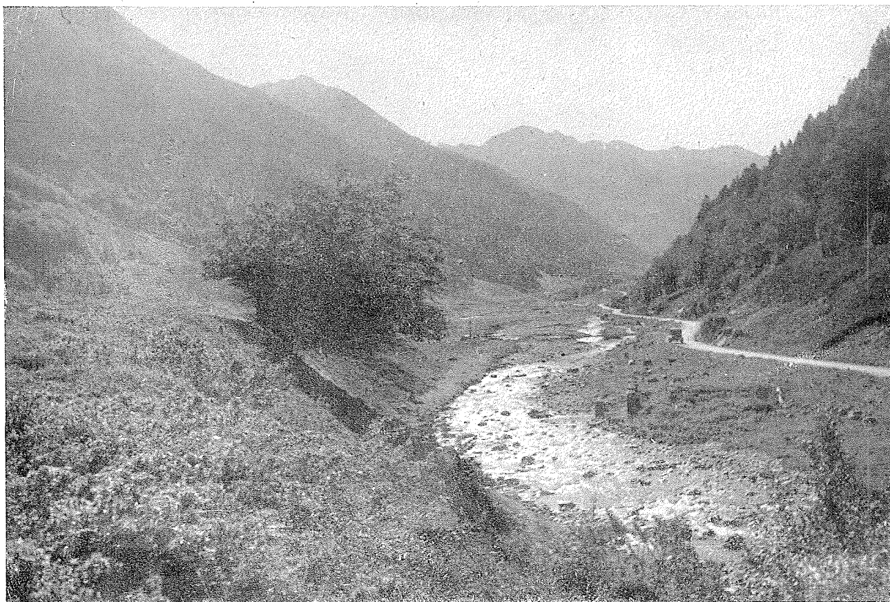
Gave du Brousset et route 134 bis en aval du pont de Fabrèges avant le débit des travaux.
