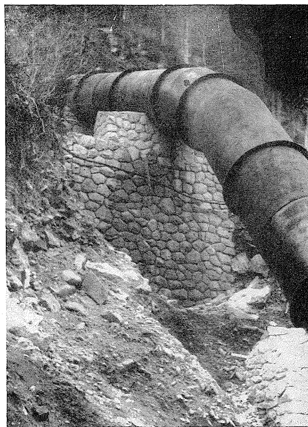
Fig. 12. — Coude supérieur de la conduite (photo Chaudronneries des Pyrénées).
