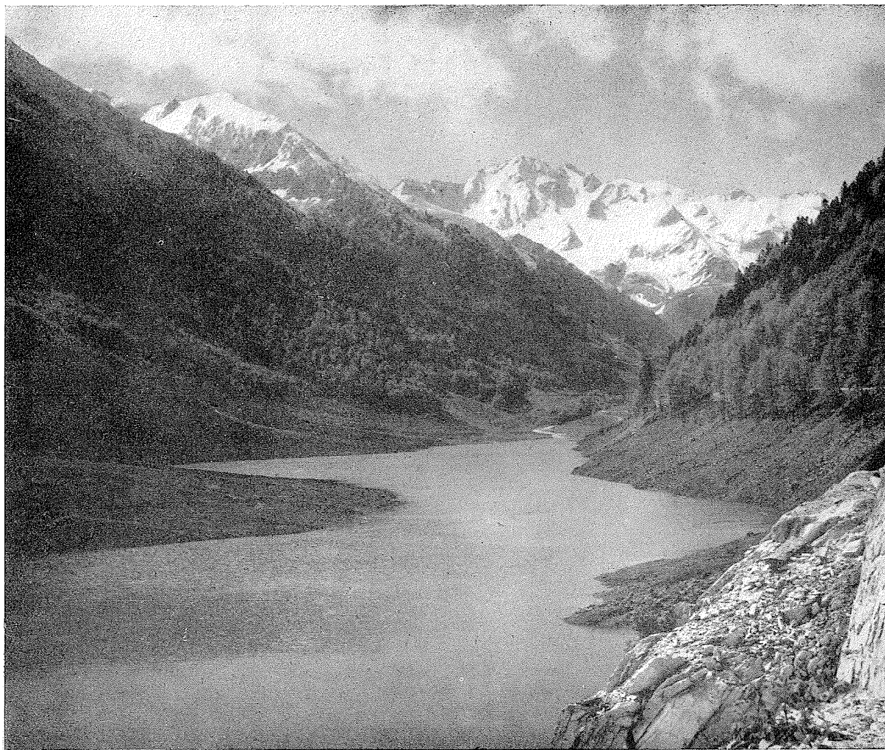
Vue amont de la retenue dans la haute vallée d'Ossau à la frontière espagnole.
