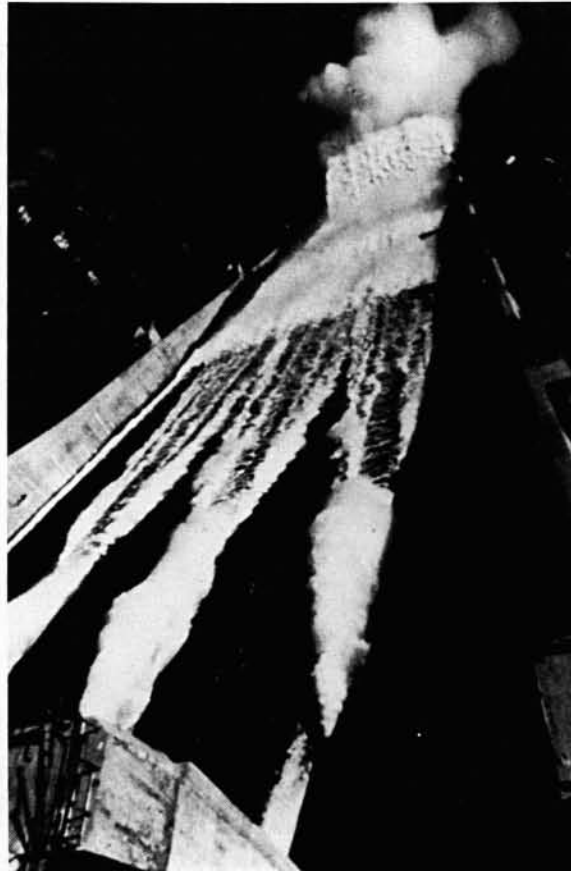
Evacuateur de crues du barrage de Foz de Areia (Brésil).
